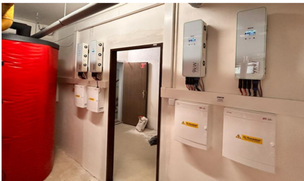
Elektroinstalace 4 jednotek ohřevu vody v bytovém domě
